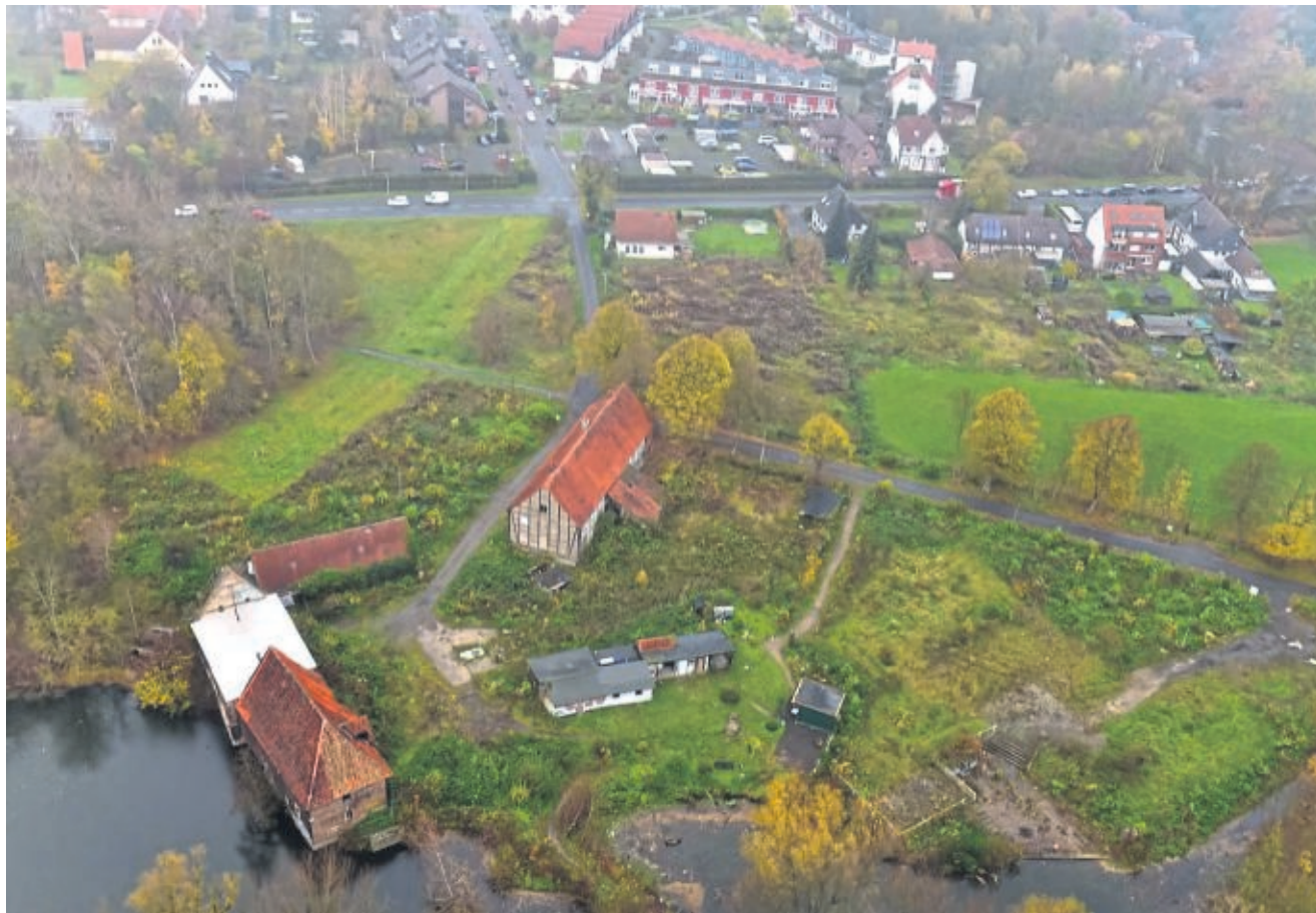
Das Baugebiet von oben: Im Norden wird die Baufirma Heckmann das Gebiet entwickeln, für den Süden steht Eigentümer Freiherr Franziskus von Ketteler in Verhandlungen mit drei „seriösen Investoren aus Hamm“. FOTO: ROTHER
